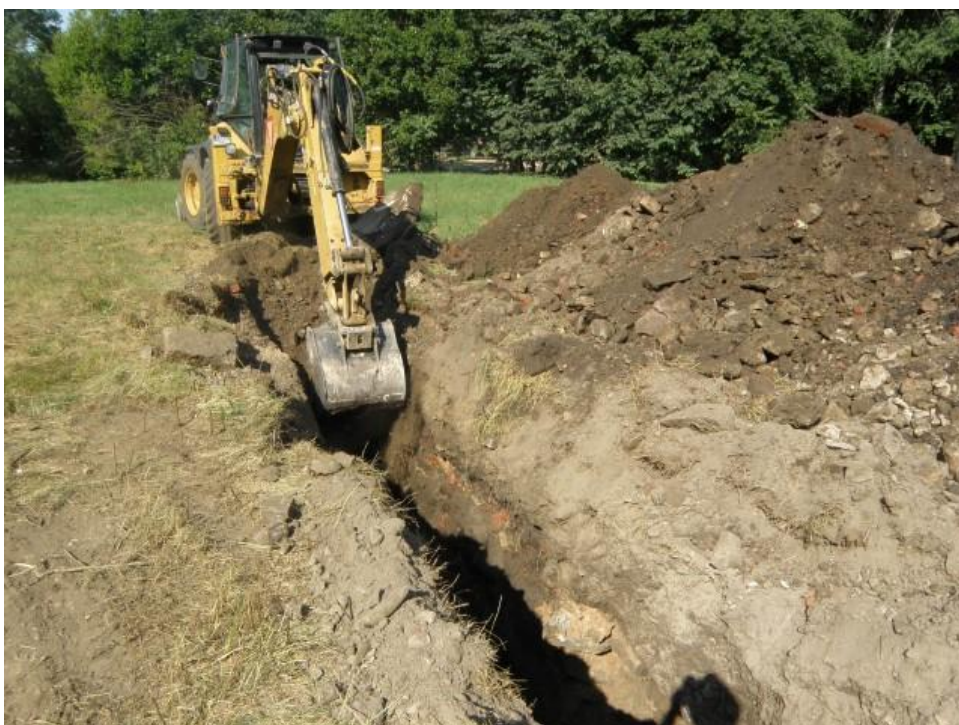
Foto 18. Vahe 1. tranšee põhjaosa. Vaade läänest.
